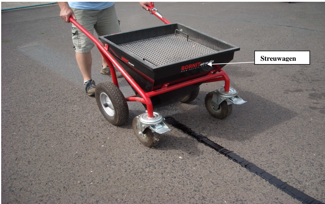
Bestreuung des behandelten Risses mit Steingemisch 0-4 mm
