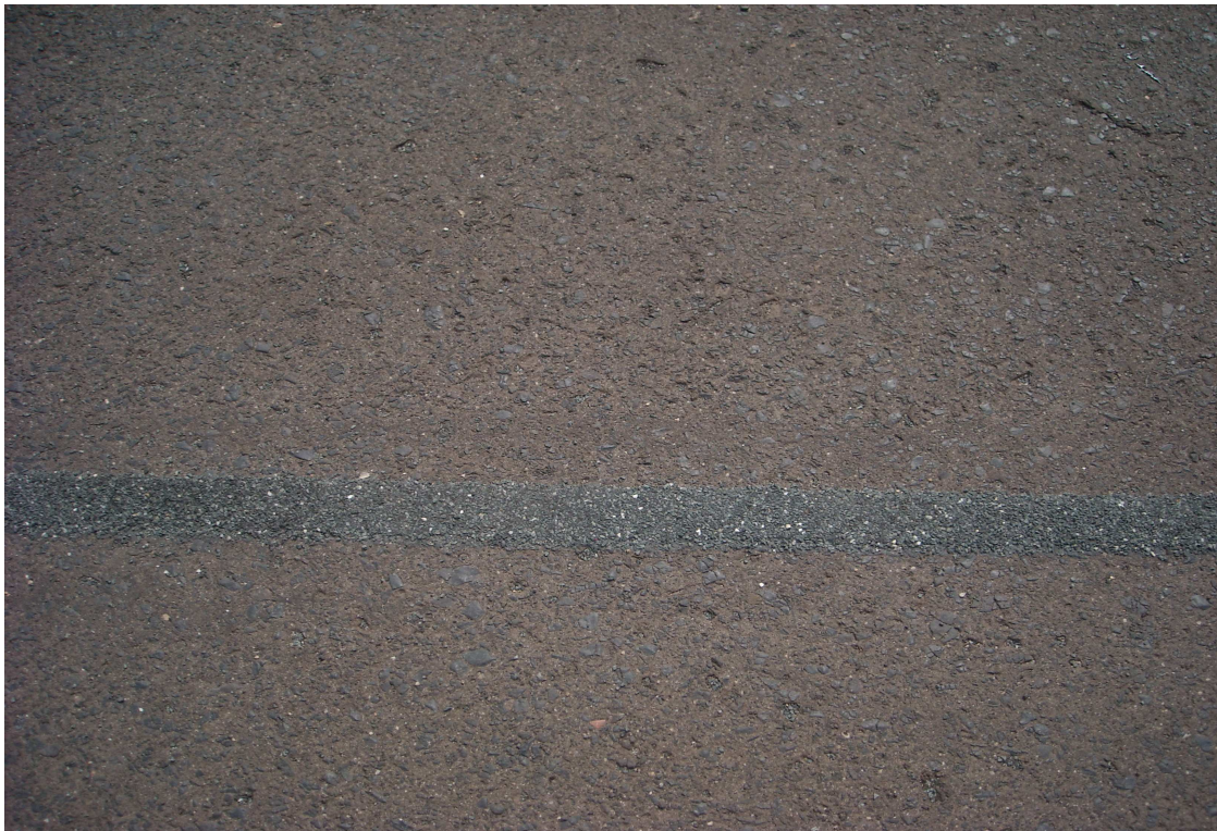
Riss nach der Behandlung mit der MasseBORNIT- Rissflex
