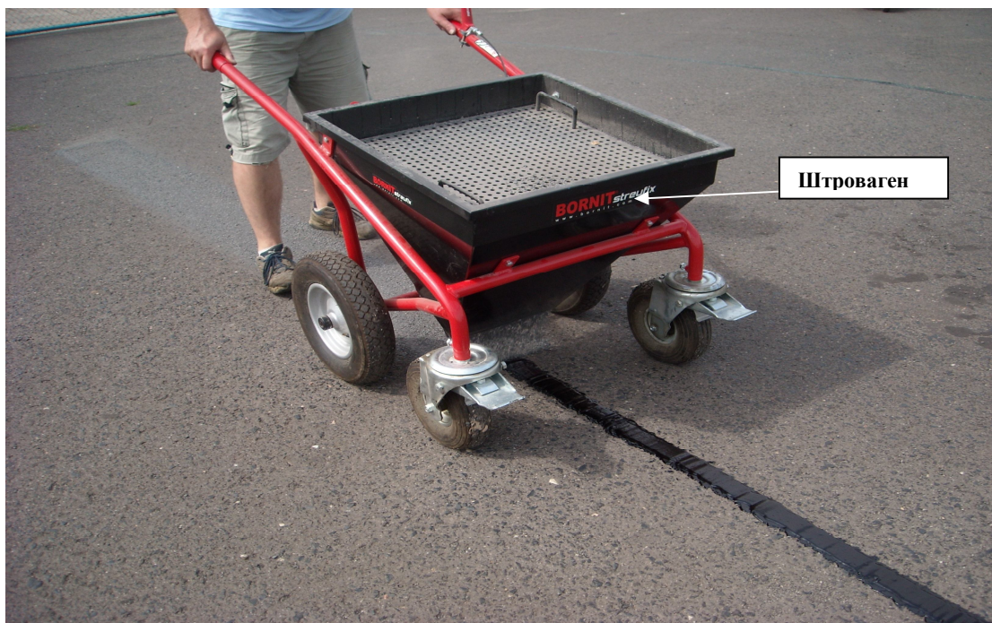
Просыпка отремонтированной трещины гравием 0-4 мм
