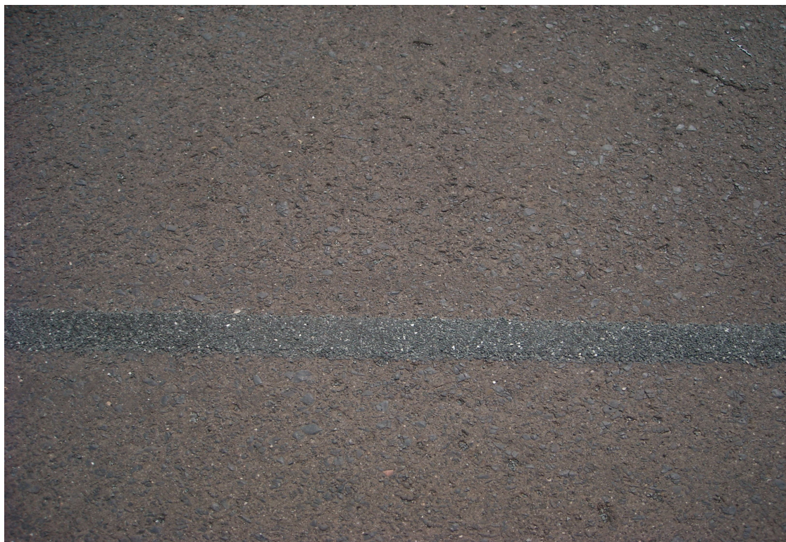
Трещина после ремонта массой BORNIT-Риссфлекс
