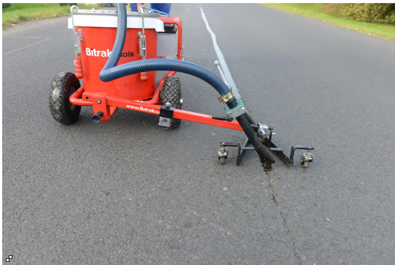
Ošetření trhliny- otevřená pracovní spára hmotou Rissflex „botičkou“
