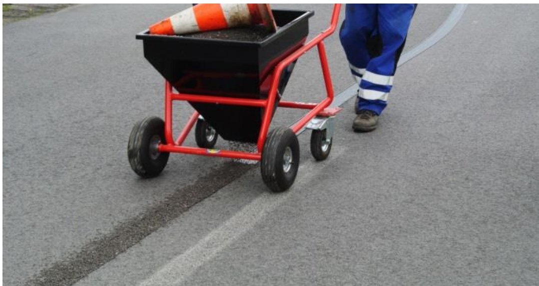
Podrcení ošetřené trhliny kamenivem 2-4 mm – posypový vozík Bitrak PVB
