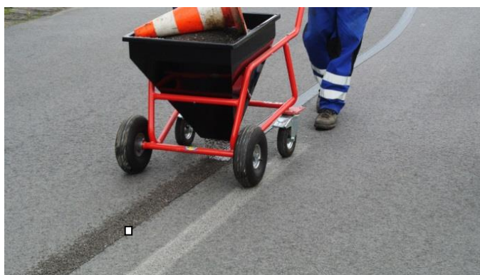
Podrcení ošetřené spáry kamenivem
