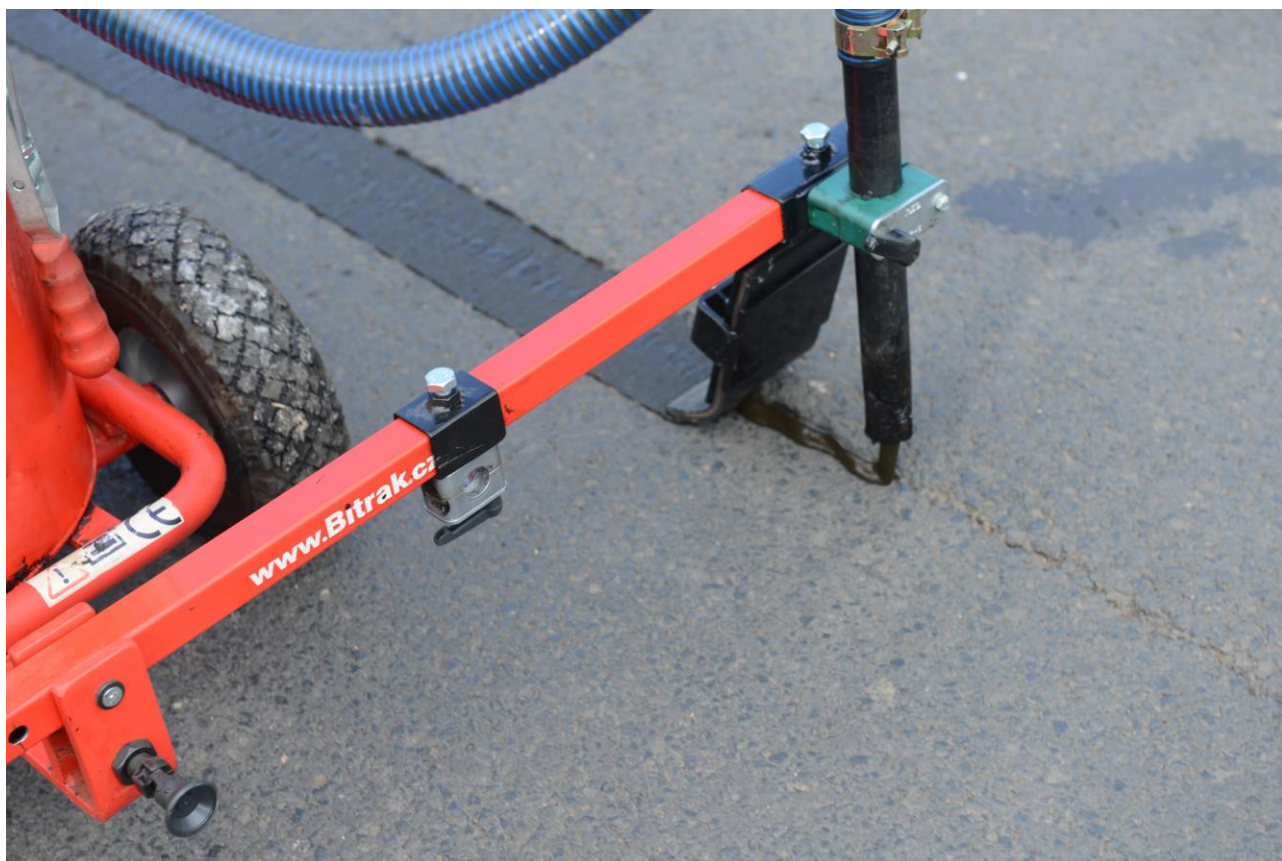
Ošetření otevřené pracovní spáry hmotou Rissflex gumovou stěrkou
