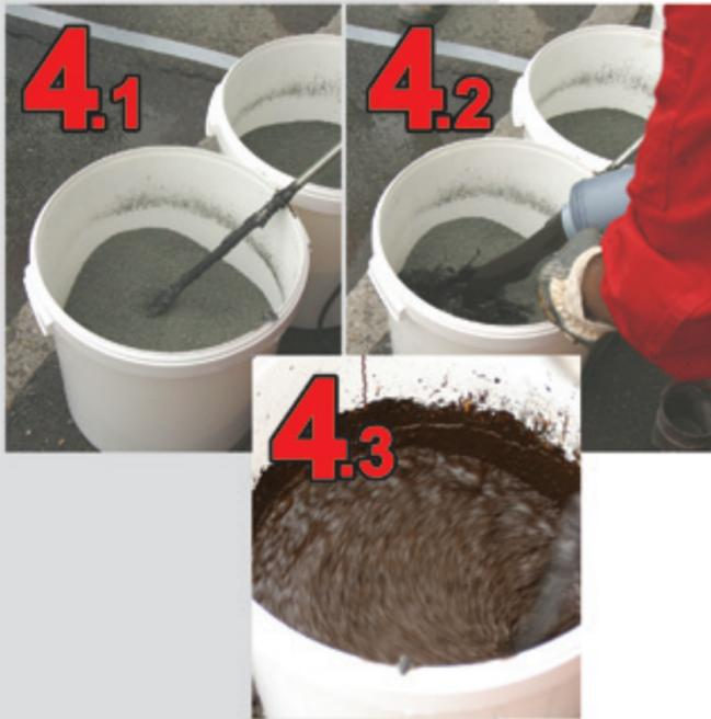
Der Edelsplitt wird zunächst unter Zugabe des Beschleunigerpulvers mit einem Rührgerät trocken durchmischt (Bild 4.1). Anschließend wird Wasser zugegeben, bis die Masse die Konsistenz eines erdfeuchten Betons hat. Zum Schluss die Bitumenemulsion hinzugeben und solange durchmischen, bis eine homogene Mischungsteht (Bild 1.3). Bei höheren Temperaturen kann etwas mehr Wasser der Mischung beigegeben werden.
