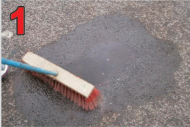
Der Asphaltbelag wird mittels Besen von stehendem Wasser bzw. Verunreinigungen gesäubert.
