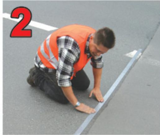
Die Ränder der zu reparierenden Fläche können mit "Steinklebeband" abgeklebt werden, um ein saubereres Endbild zu erzielen. (Bild 2). Anschließend wird die zu reparierende Fläche mit einem Quast leichtvorgenässt um einen besseren Verbund zum Untergrund zu erhalten (Bild 3).
