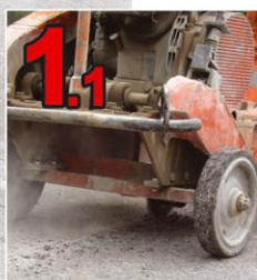
Spára se vyřízne na zalitelnou šířku (max. 2 cm) (Obrázek 1). Poté je třeba vyříznutou spáru do čista vyfouknout stlačeným vzduchem (Obrázek 2) nebo vyčistit kartáčovacím strojem. Pro zajištění požadované přilnavosti zalévací hmoty musí být boky spáry ošetřeny přednátěrem BORNIT®-Haftgrund - příl- navý základ (Obrázek 3). Toto lze provést štětcem nebo stříkacím zařízením. Zalévací práce by mely být prováděny pouze při teplotách nad +5°C (popř. předem ošetřit teplým vzduchem!).
